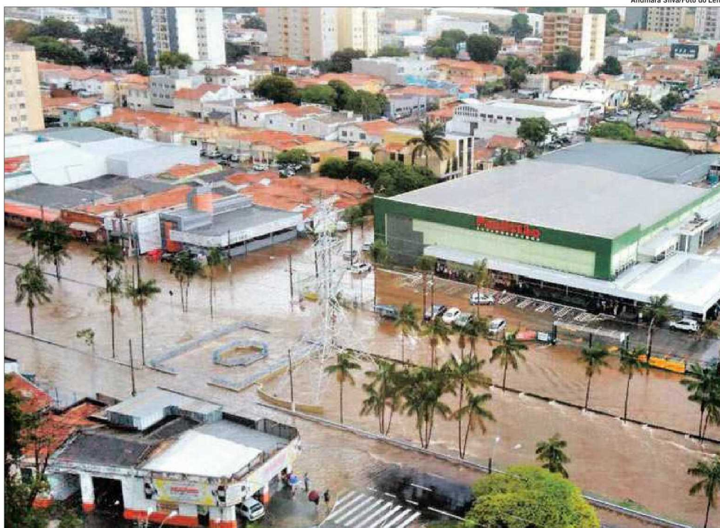
O Córrego Serafim na Avenida Orosimbo Maia transbordou atingindo a via no cruzamento com a Avenida Brasil e com a Rua Coelho Neto
