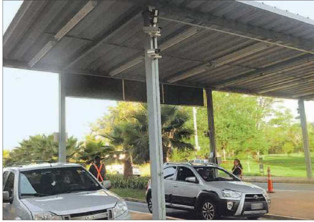
Portaria de entrada da universidade passa a contar com câmeras de vigilância: segurança e controle
