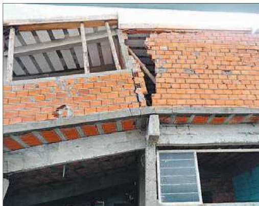
Vista do sobrado em obras que desabou no bairro Cidade Singer (estrutura danificada no destaque abaixo), provavelmente em decorrência do solo encharcado; abaixo, à direita, Centro de Saúde com atendimento suspenso ontem no Parque Floresta, após parte do forro desabar
