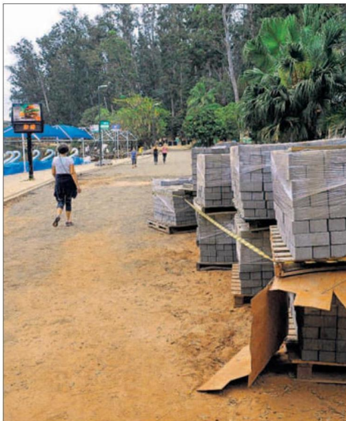
Projeto inicial prevê a instalação dos blocos do Portão 1 até a caravela
