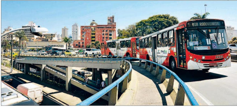
Movimento de veículos no Viaduto Vicente Cury, na região central de Campinas, que já teve problema com acidente e queda
