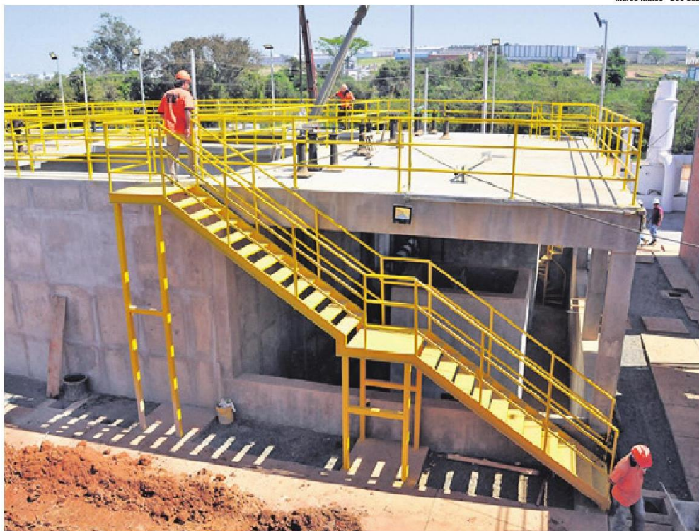
Obra de ampliação da ETA III está em fase final e deverá expandir a oferta de água para a Zona Sul de Indaiatuba
