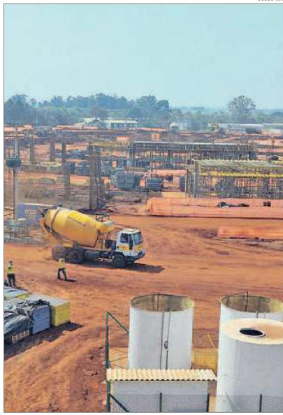
Obras do Sirius: até este importante projeto está sofrendo com medidas
