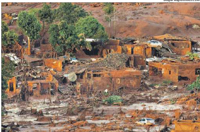
Lama de rejeitos que tomou o subdistrito de Bento Rodrigues após rompimento da barragem de Fundão
