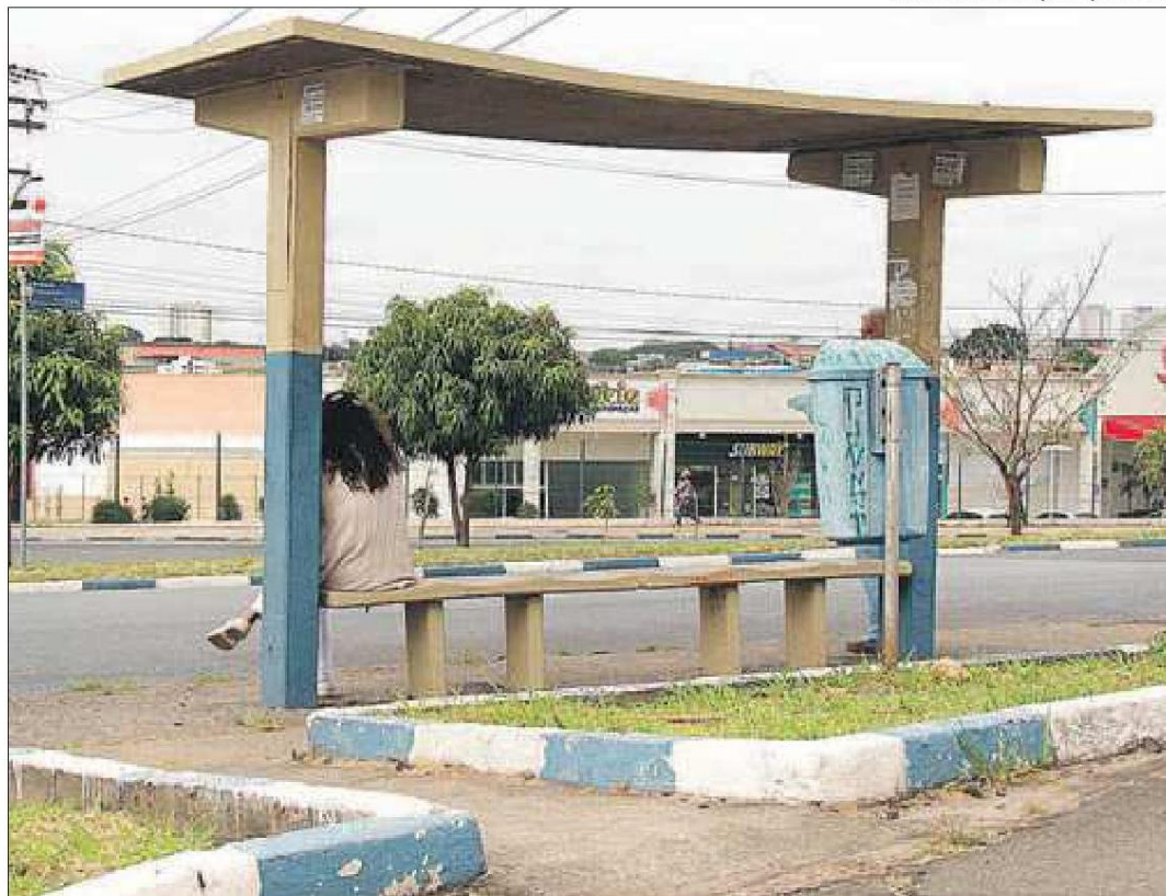
Ponto de ônibus com estrutura de concreto no Jardim Campos Elíseos: cidade tem 5 mil paradas
