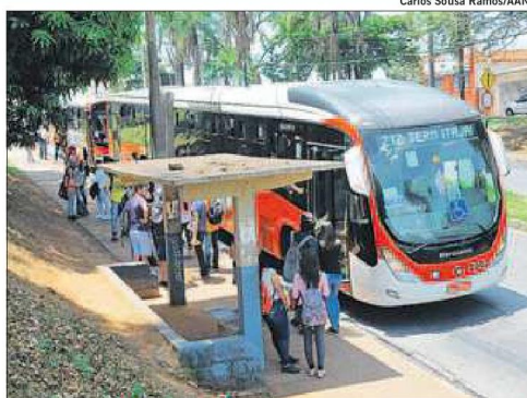
Na Vila Teixeira, ponto feito de concreto, mas antigo e com problema
