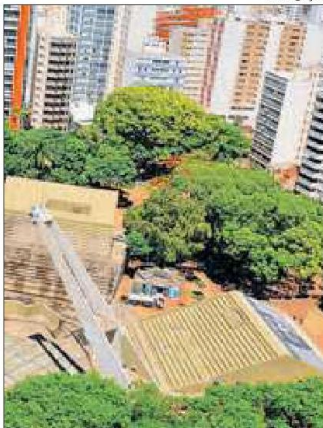
Vista aérea do prédio onde fica o teatro interno do Centro de Convivência
