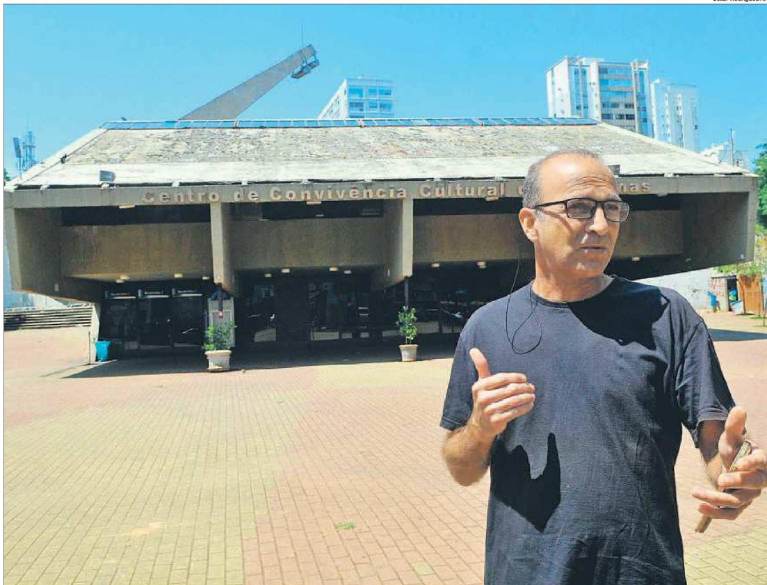
Engenheiro-civil Paulo Eduardo Pires de Almeida, especialista em patologia de estruturas, em frente ao prédio do teatro do CCC: “Quando vai ver o detalhamento, são poucos que têm”
