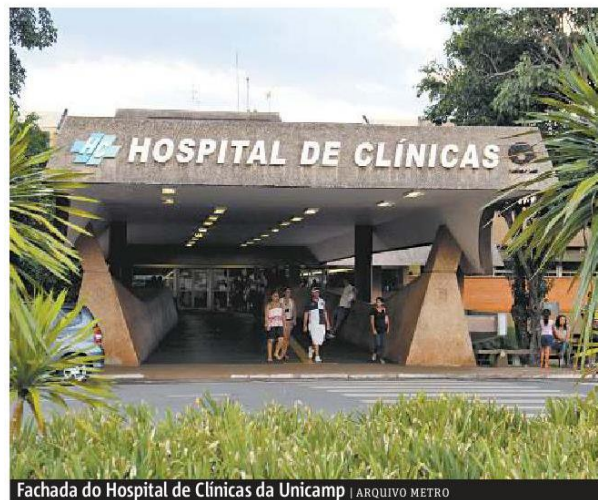
Fachada do Hospital de Clínicas da Unicamp | ARQUIVO METRO
