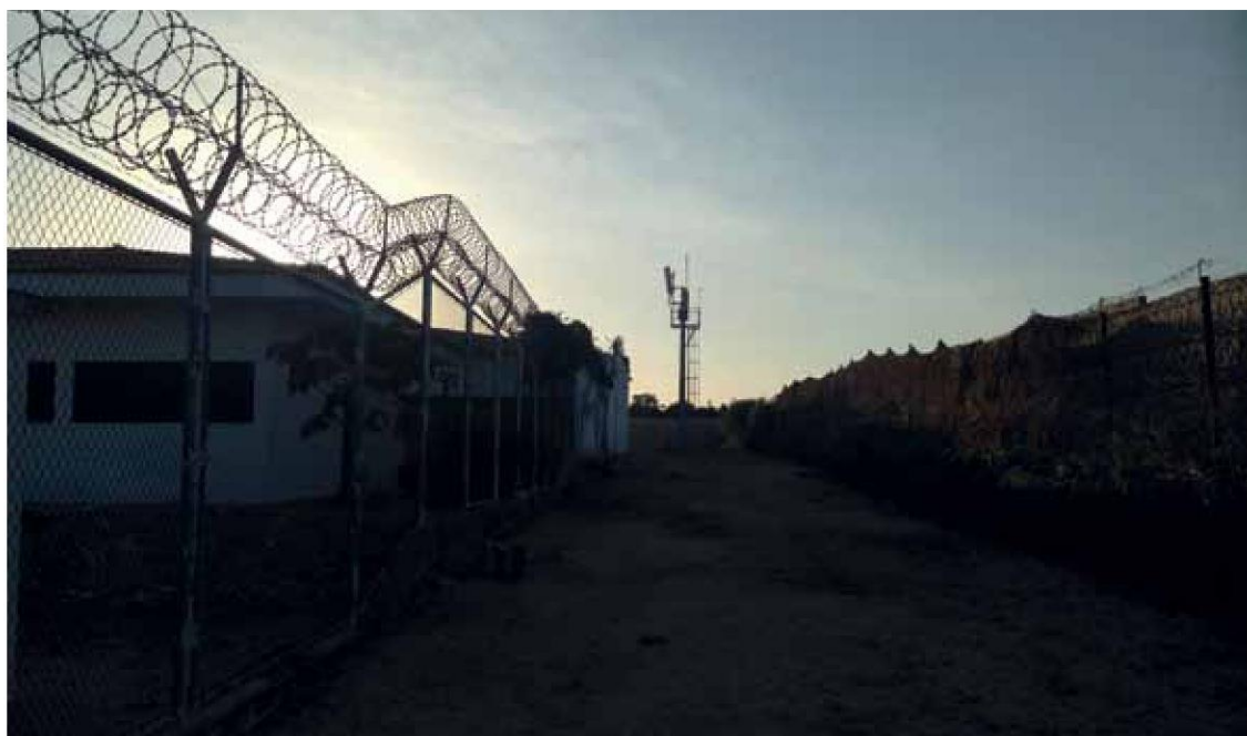
Sistema para bloqueio de comunicações (à esq.) na Penitenciária Estadual de Parnamirim, no Rio Grande do Norte, e a instalação de uma das torres e equipamentos no mesmo presídio (à dir.)
