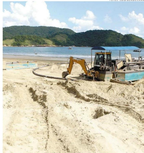
As estruturas que formam os geobags são levadas até o fundo mar. Lá, as barreiras contra a erosão são preenchidas com uma mistura de areia e água sugada por uma tubulação
