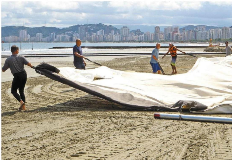
As estruturas que formam os geobags são levadas até o fundo mar. Lá, as barreiras contra a erosão são preenchidas com uma mistura de areia e água sugada por uma tubulação
