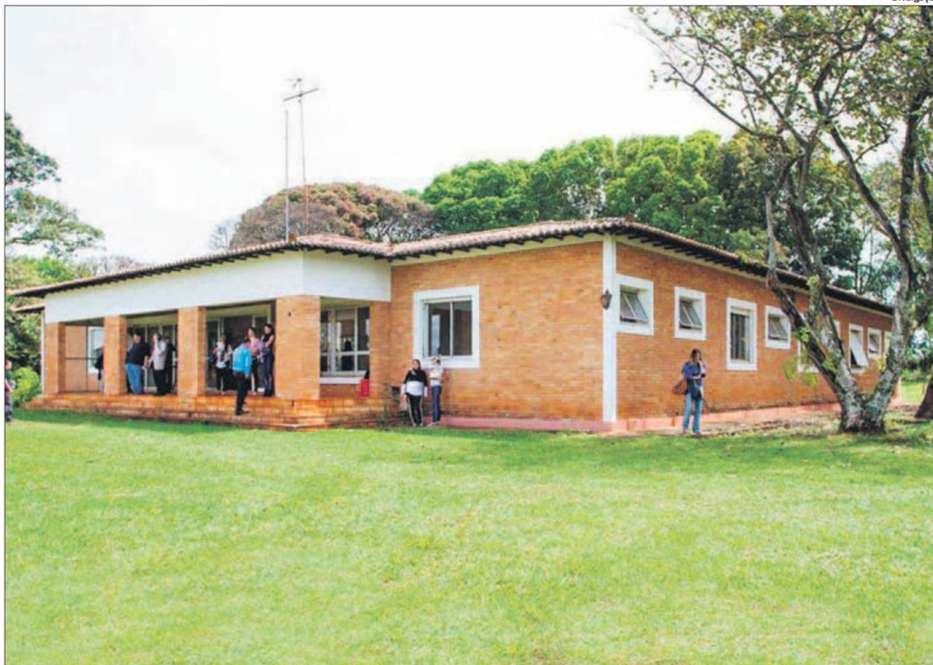
Fazenda Argentina, adquirida pela Unicamp em 2014: em troca do uso do espaço, Decor fará melhorias no piso, telhado e redes elétrica e hidráulica
