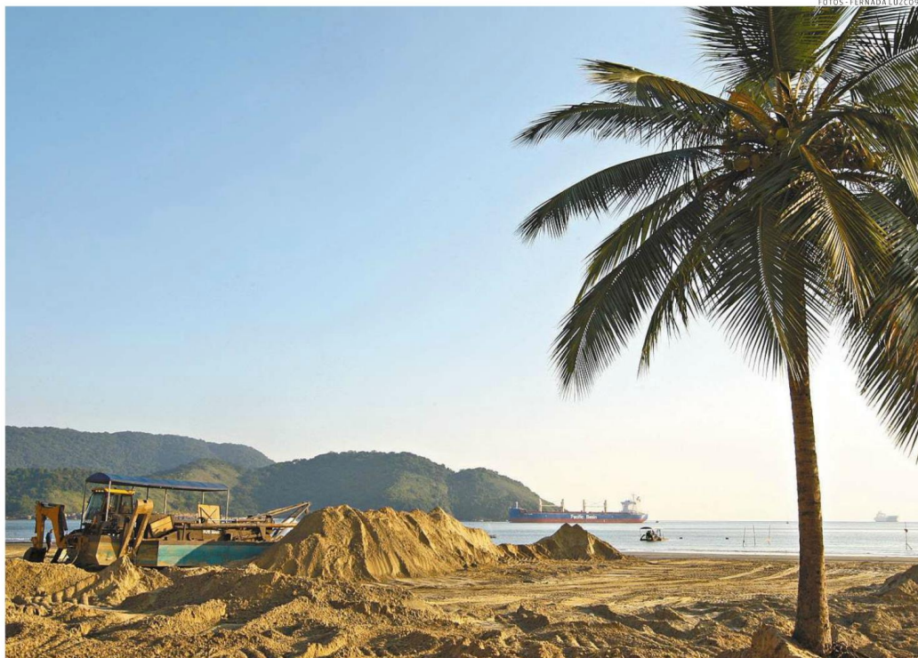
Durante a obra, 49 bags geotêxtis preenchidos com areia da praia foram instalados no fundo do mar em um trecho de cerca de 500 metros
